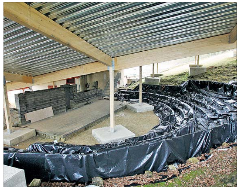
Die steinernen Sitzreihen des Theaters unter der provisorischen Überdachung wurden im vergangenen Jahr konsolidiert. (FOTO: SERGE WALDBILLIG)
